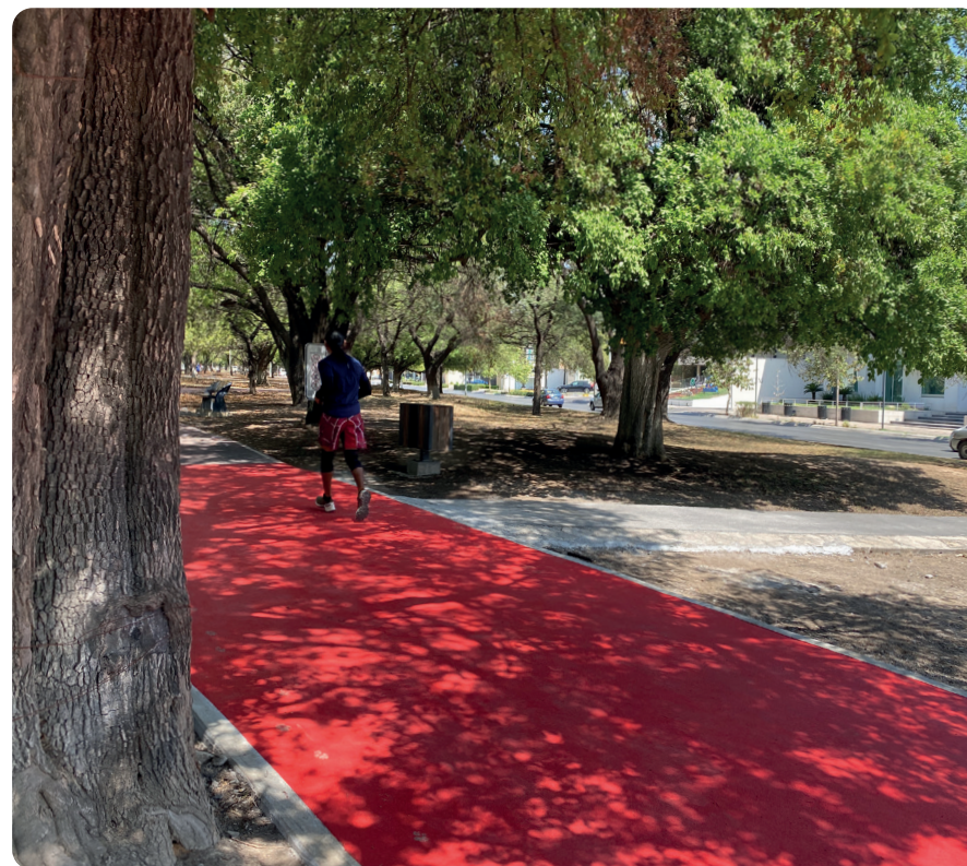
Vitapista rehabilitada en Las Calzadas.
